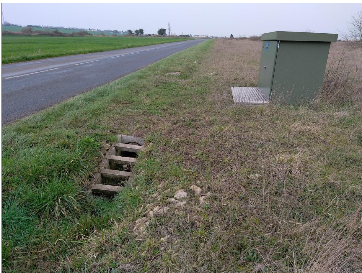
Figure 13 : Illustrations photographiques des transformateurs, observés le 15/03/2022
